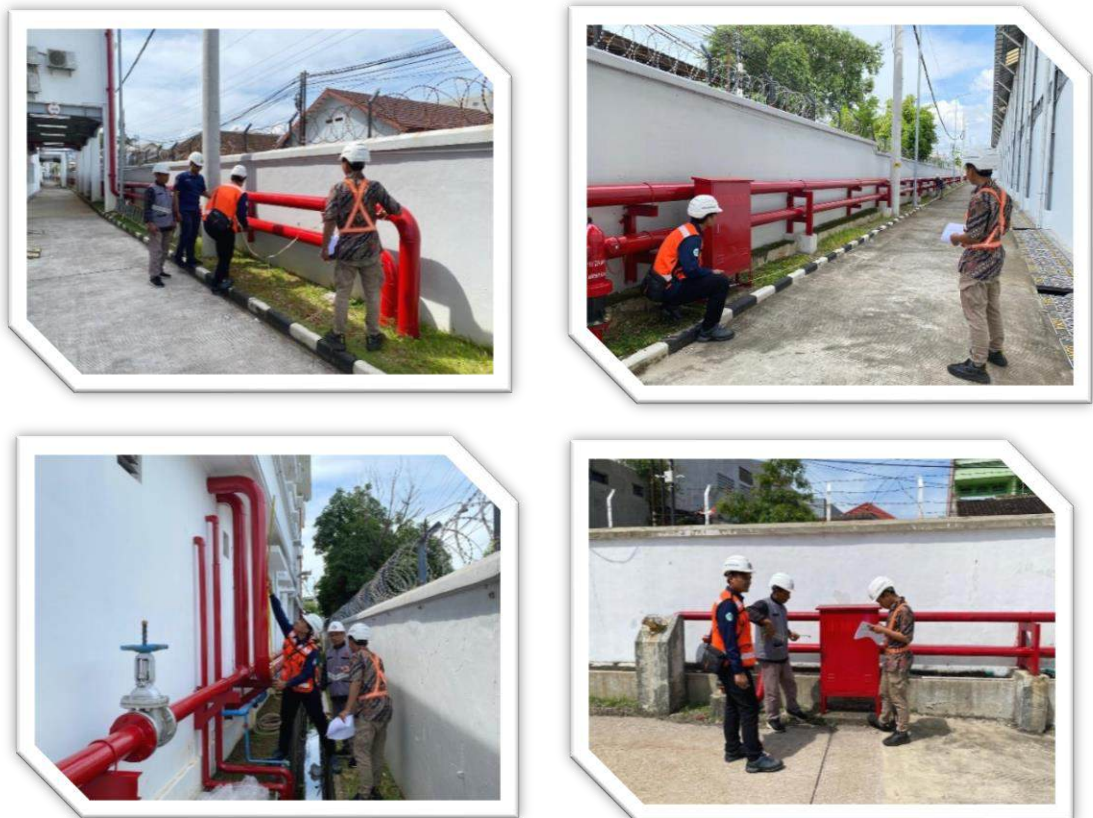
Gambar 2.18 Pengecatan Pipa Hidran
