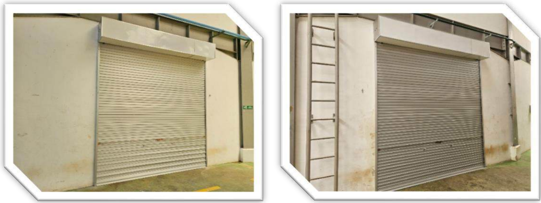
Gambar 2.17 Pembuatan Rolling Door
