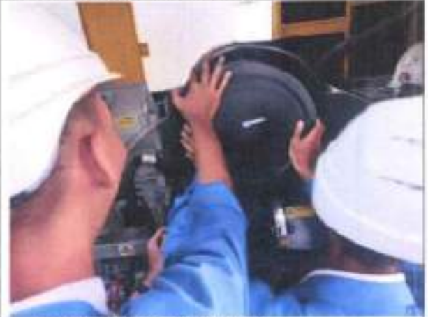
Pemasangan Filter Udara Genset PERKINS SEV551F/4
