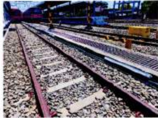
Lampu sisi Selatan
