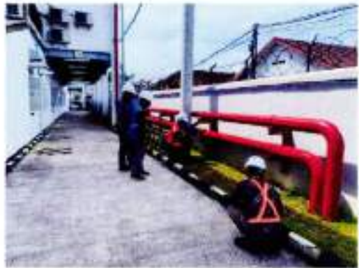
Pengecatan Pipa Hidrant
