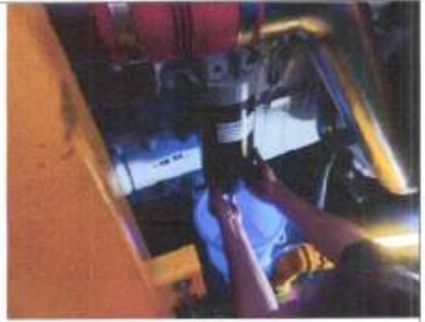
Pemasangan Filter Oli Genset CH10929
