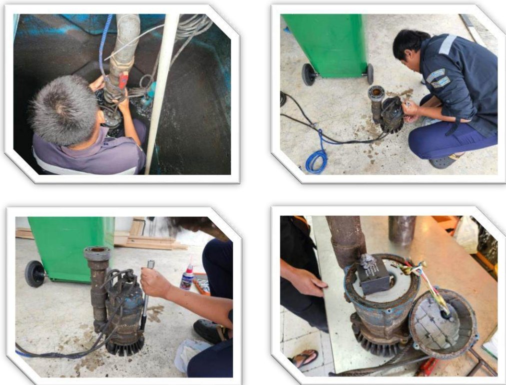
Gambar 2.14 Perbaikan Pompa Tanki Biosant
