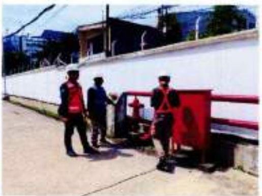
Pemeriksaan Cat Box Hidrant
