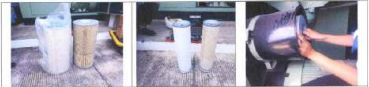
Pemasangan Filter Udara Internal dan External
