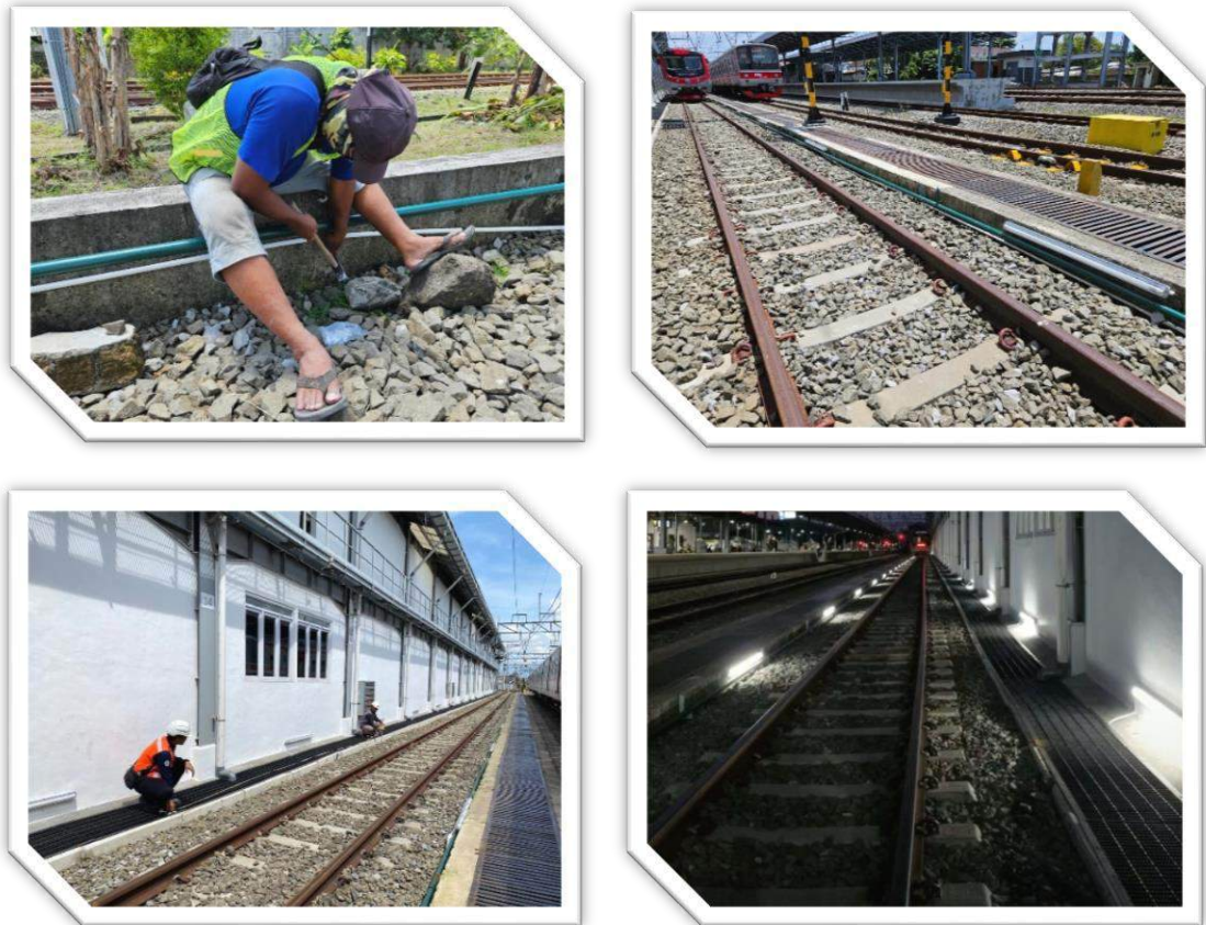
Gambar 2.15 Pemasangan Lampu Penerangan Perawatan Jalur 6
