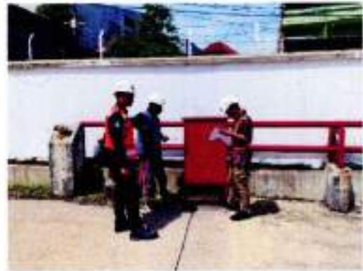
Pengecatan Box Hidrant
