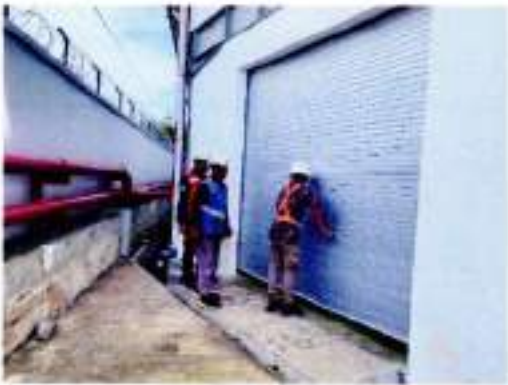
Rolling Door Sisi Barat
