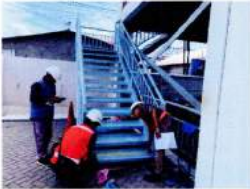
Pengecatan Tangga Mushola
