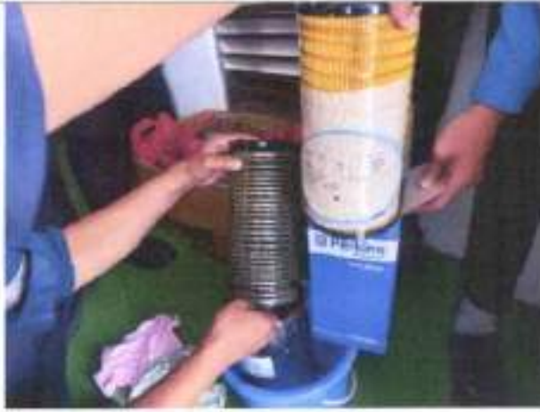
Pemasangan Filter Oli Genset CH10929
